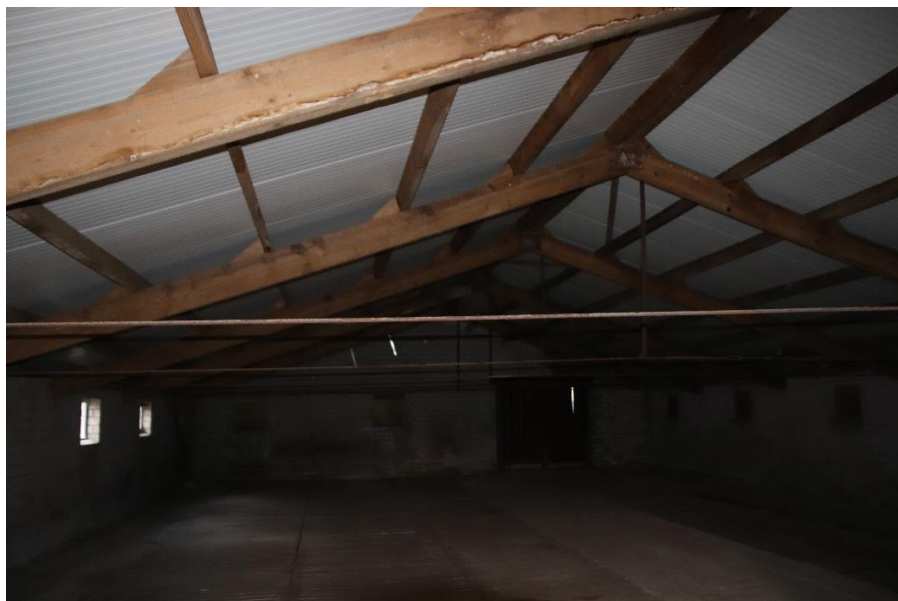
Foto 2: Binnenzijde van een van de stallen met nieuwe daken. Nergens zijn sporen aangetroffen die duiden op het gebruik van broedvogels zoals boerenwaluw, mede omdat hier geen openingen zijn die toegang bieden
