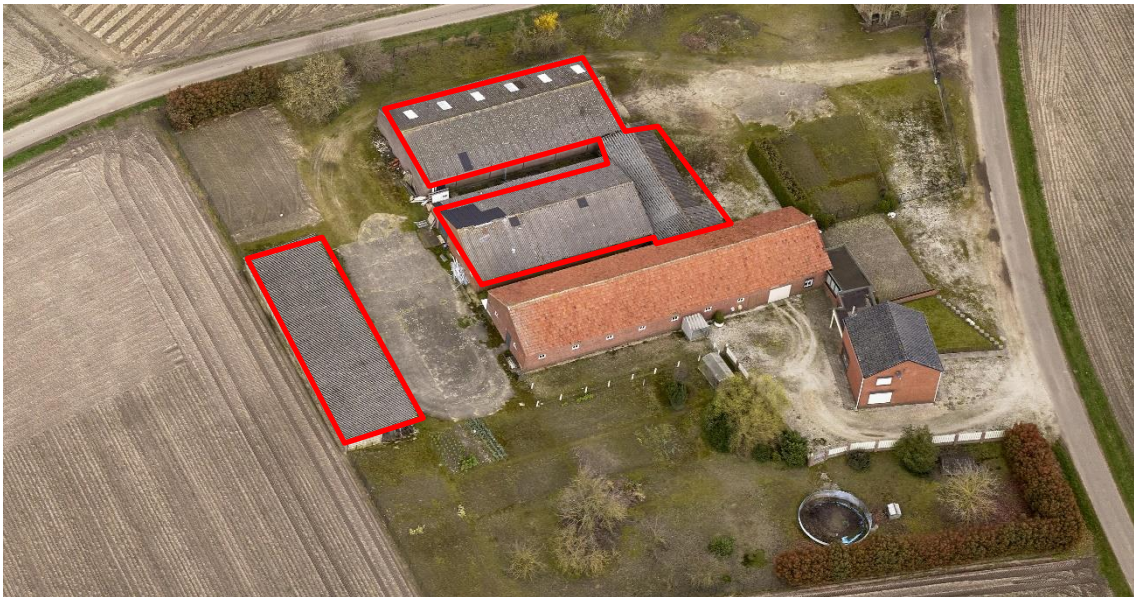
Afbeelding 2: Luchtfoto van onderzoekslocatie, d.d. 20-3-2020. Rode contour is asbestdak
