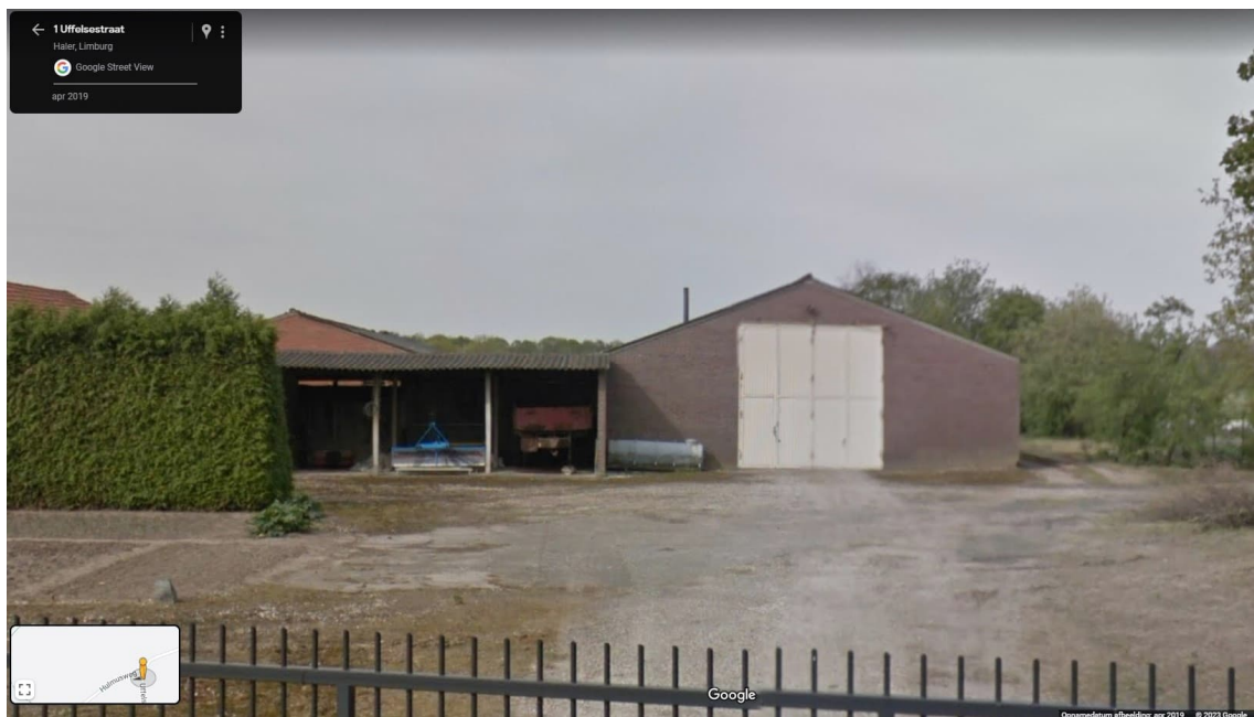
Afbeelding 2: Street view afbeelding van de voormalige tank met de schuur die daarna is afgebroken (april 2019).
