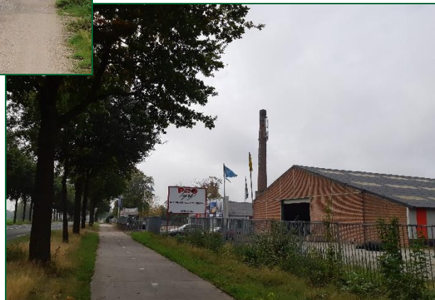
Afbeelding. Aanzicht hoveniersbedrijf en bedrijfsverzamelterrein vml. steenfabriek
