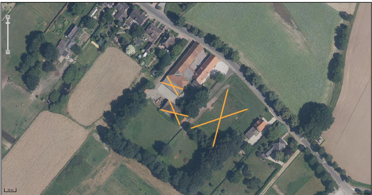
Figuur 3: Luchtfoto met daarop de te slopen bouwwerken
