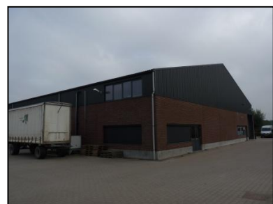
Figuur 8. De loods verkeerd in nieuwbouw conditie.*
