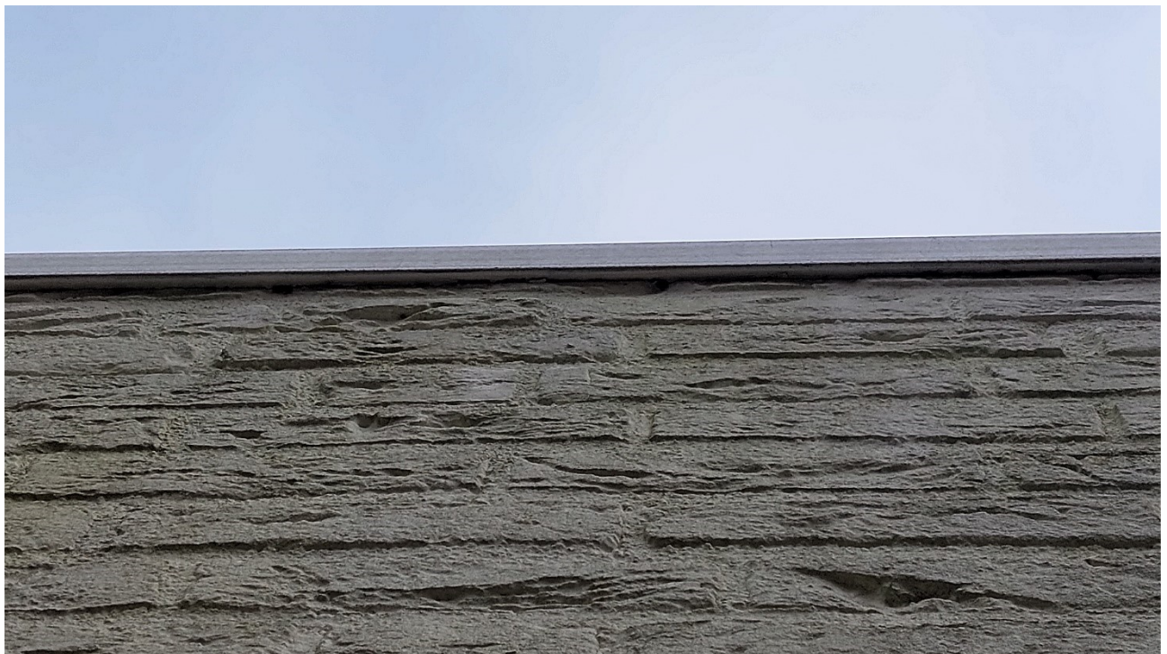
Figuur 4.4.3. Het daktrim sluit nauw aan op de gevels.
