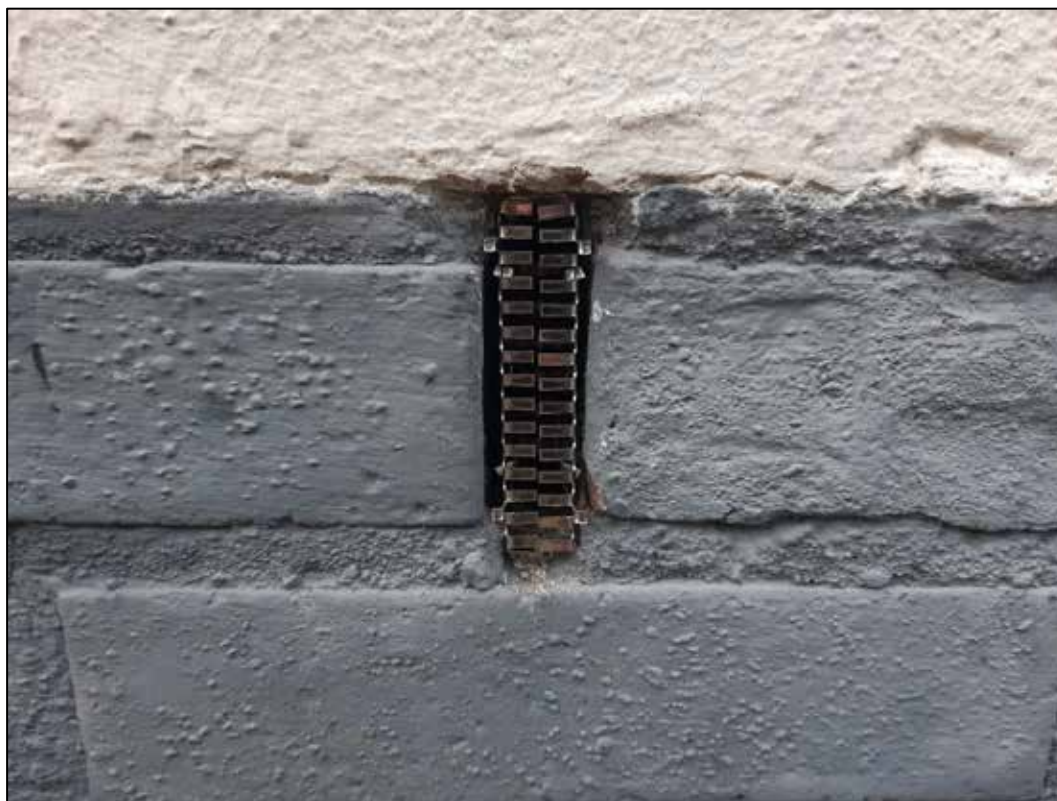
Foto 3: alle stootvoegen zijn afgesloten met stootvoegroosters.
