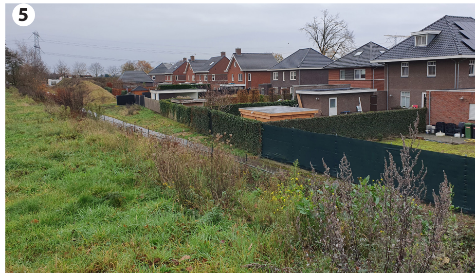
Zicht vanaf de grondwal richting het zuidoosten
