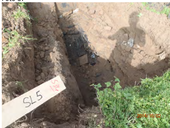
Foto 5: sleuf 5 met "afval" houdend materiaal.
