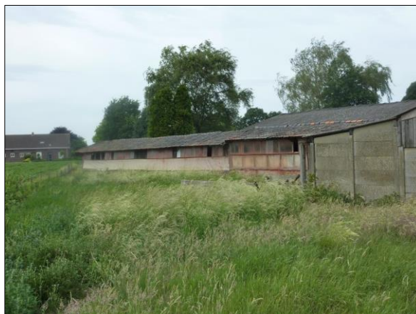
Afbeelding 8: Zicht op gedeeltelijk te slopen stal nr. 2
