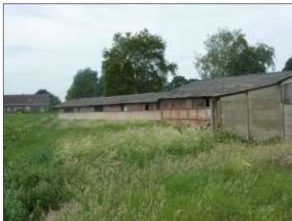
Afbeelding 8: Zicht op gedeeltelijk te slopen stal nr. 2
