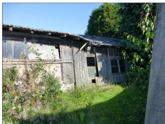
Oude varkensschuur, enkelsteen, niet geïsoleerd
