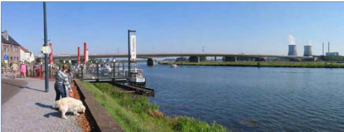
Afbeelding 49 Maasboulevard Wessem, met uitzicht op de Clauscentrale (foto: onbekend)
