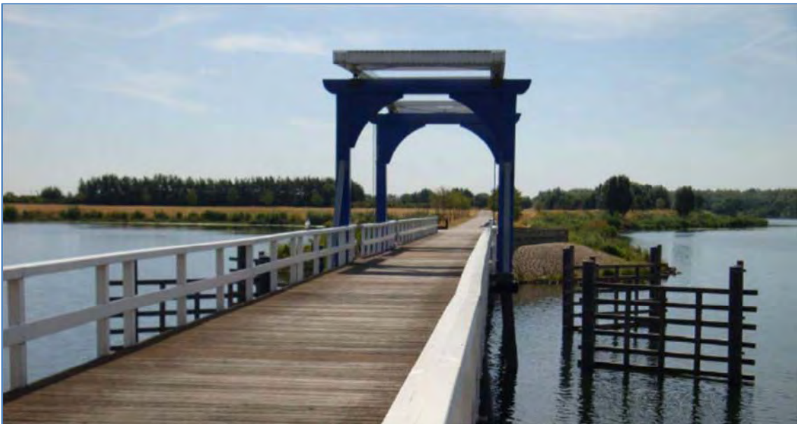
Afbeelding 47 Hefbrug grote Hegge Groeskamp (foto: P. Vossen)
