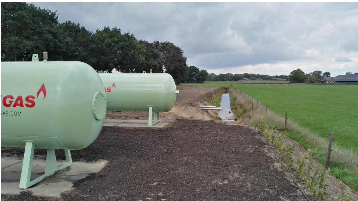
Figuur 20: De Nieuwe hemelwaterinfiltratiesloot en propaangastanks (gefotografeerd tegen noordwesten).
