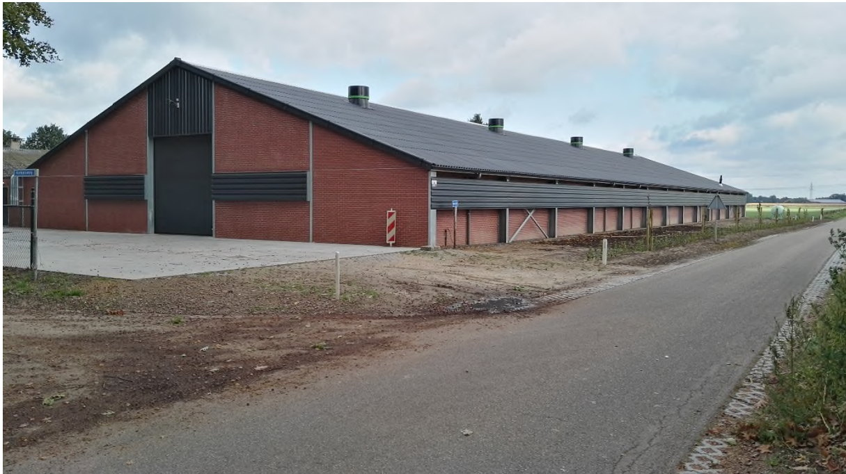
Figuur 19: Nieuwe Kuikenstal met aan de rechterzijde de Hunselerdijk (gefotografeerd tegen noordoosten).
