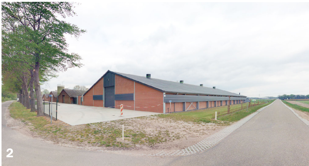
Aanzicht zuidzijde pluimveestallen - Cyclomedia
