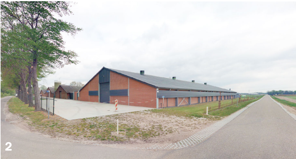
Aanzicht zuidzijde pluimveestallen - Cyclomedia
