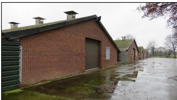
Foto 1. Het zuidwesten van de vier te slopen stallen
