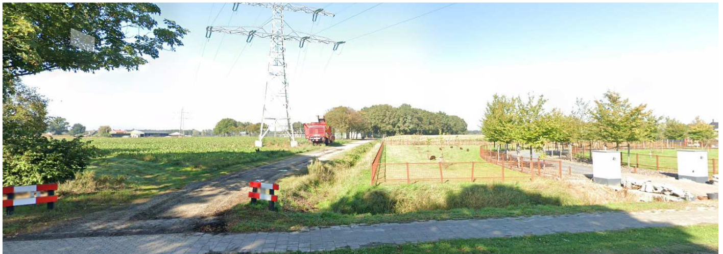
Figuur 7 Het hoogspanningsstation vanaf de Kelperweg, met op de achtergrond het oude bosperceel
