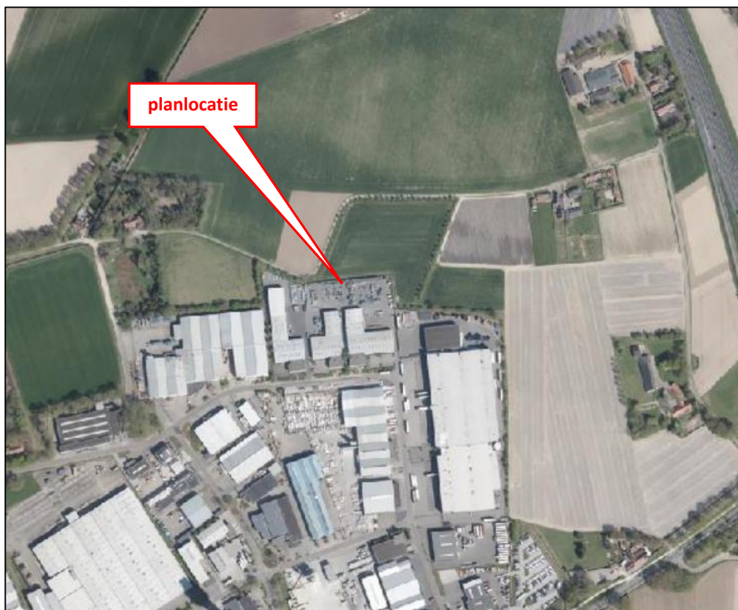
Figuur 1. Luchtfoto met ligging bedrijfslocatie
