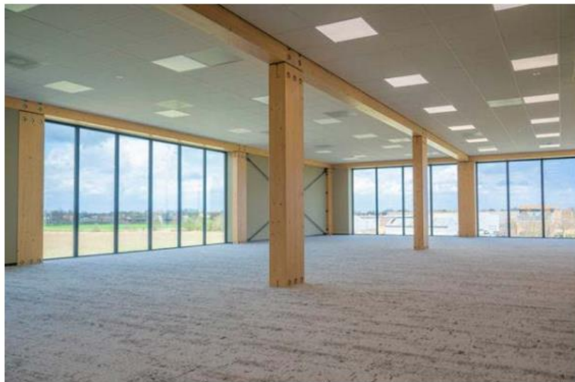
Figuur 30. Kantoorbebouwing bestaande uit houten modules
