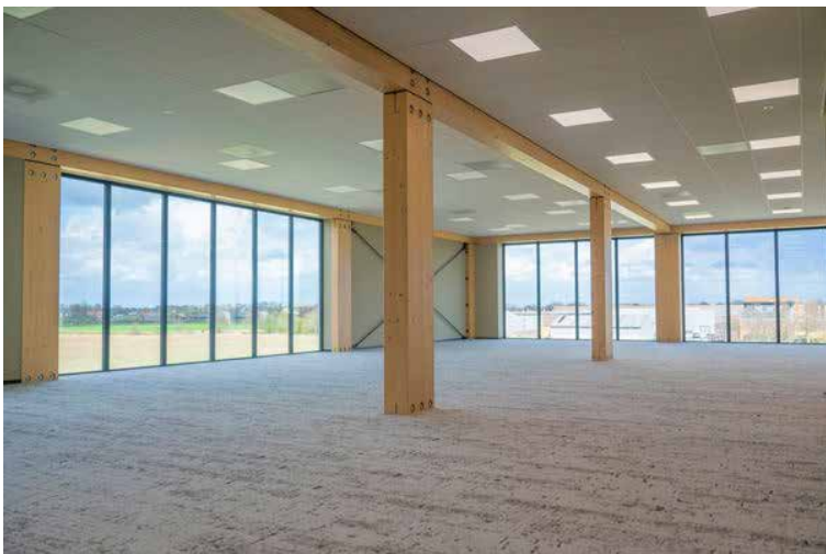
Figuur 31. Kantoorbebouwing bestaande uit houten modules
