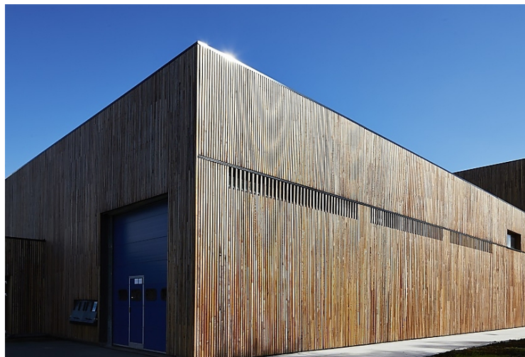
Figuur 35. Houten gevelvoering
