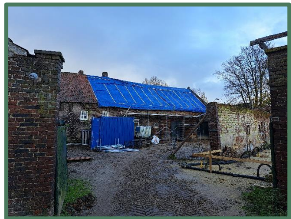
Het dak is gedeeltelijk verwijderd
