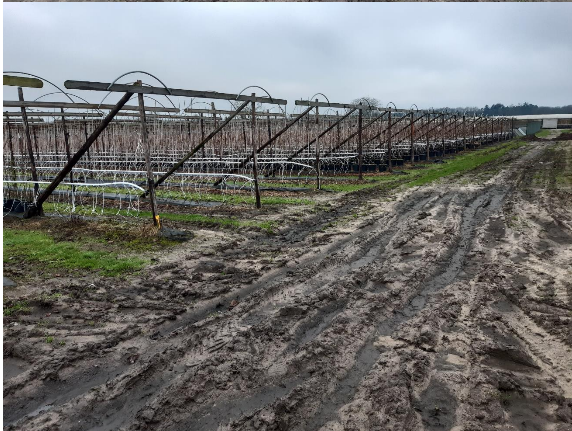
Foto's van de west- en noordzijde (d.d. 27 januari 2022)
