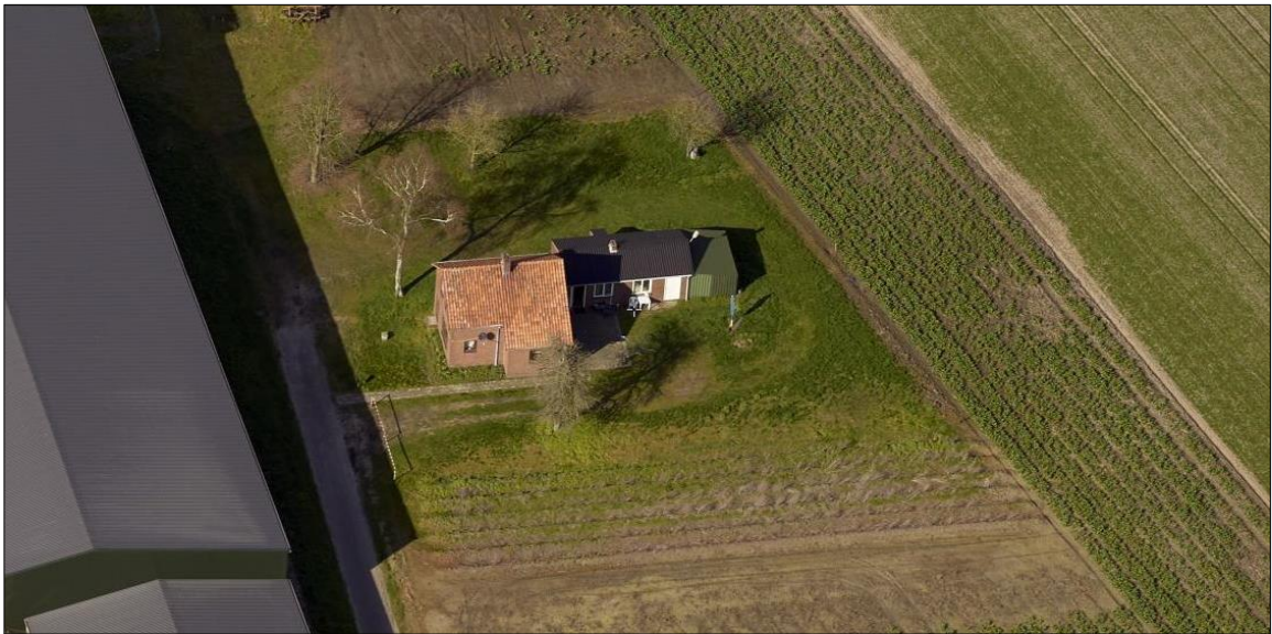
Vogelvluchtbeeld van de te slopen woning Heide 16
