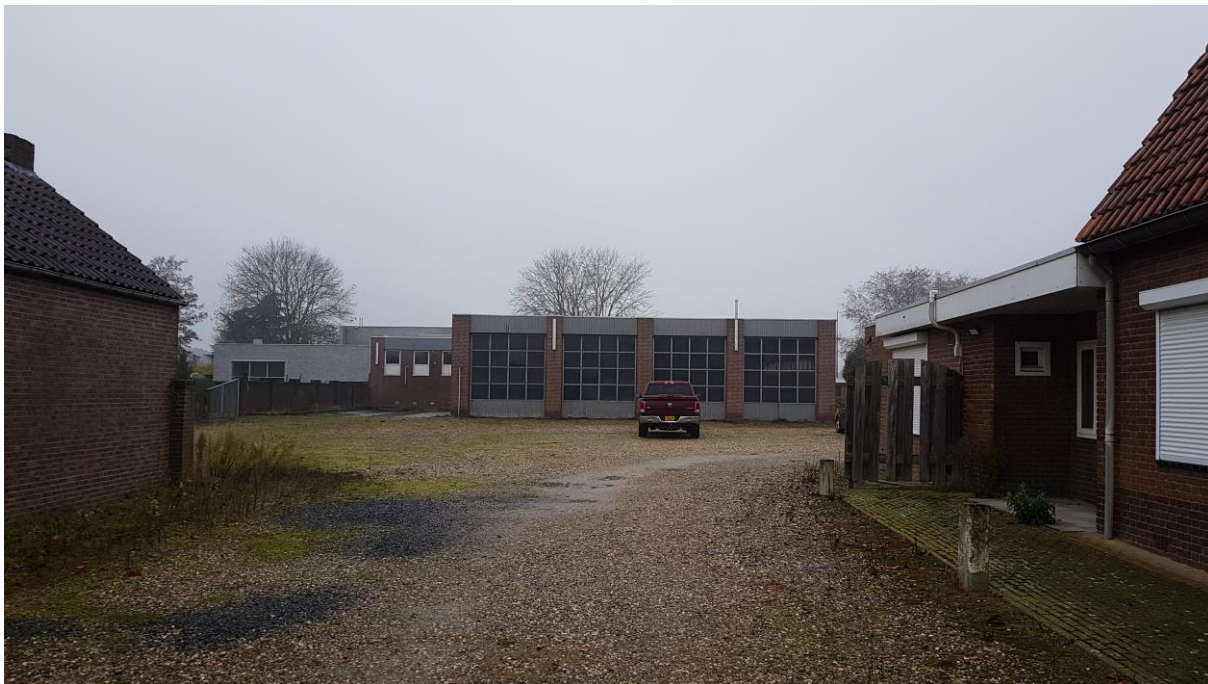
Foto 1: Terrein vanaf de Markt, met de te slopen hal en kantoor.
