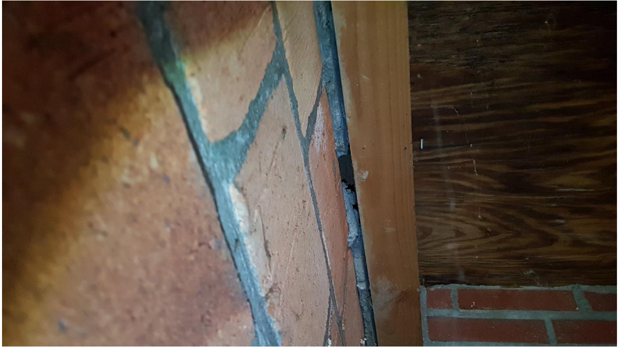
Foto 23: opening naar de spouw hieronder zijn ook keutels aangetroffen.
