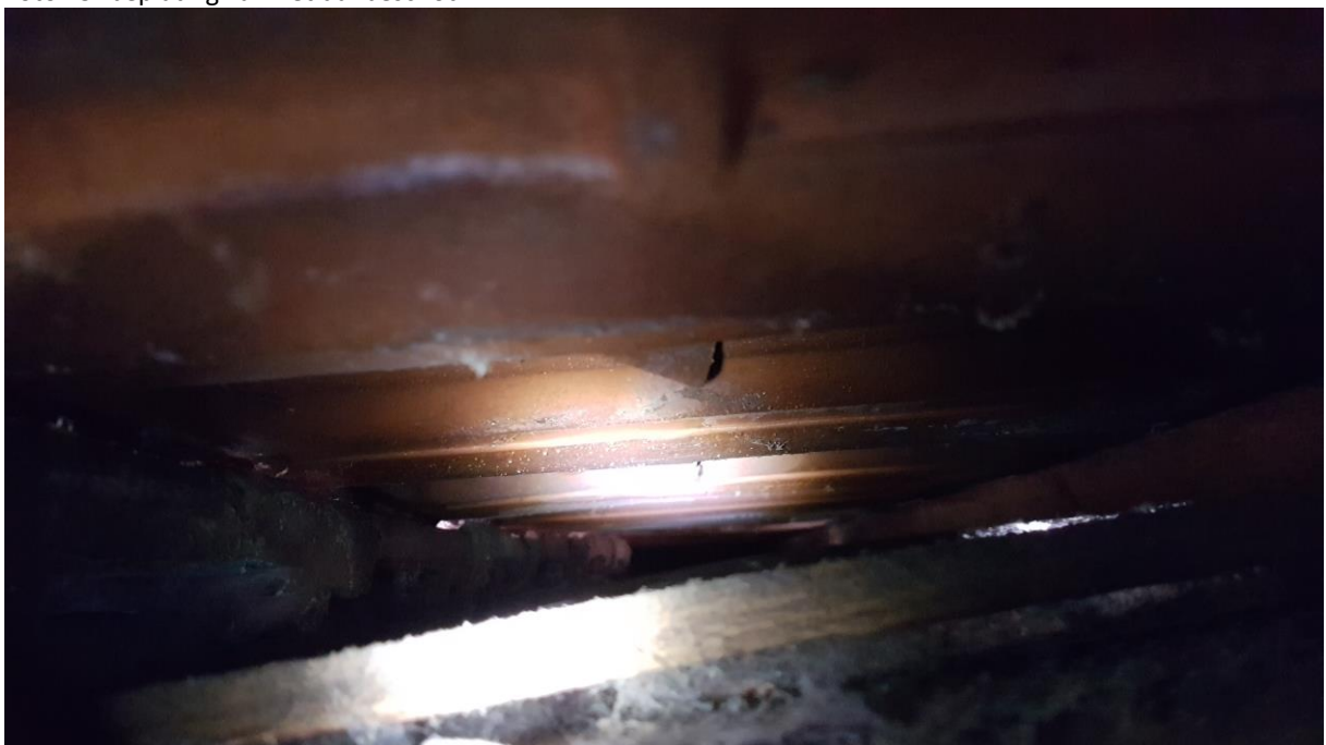
Foto 20: de ruimte tussen het dakbeschot en de pannen (meerdere plekken bekeken).
