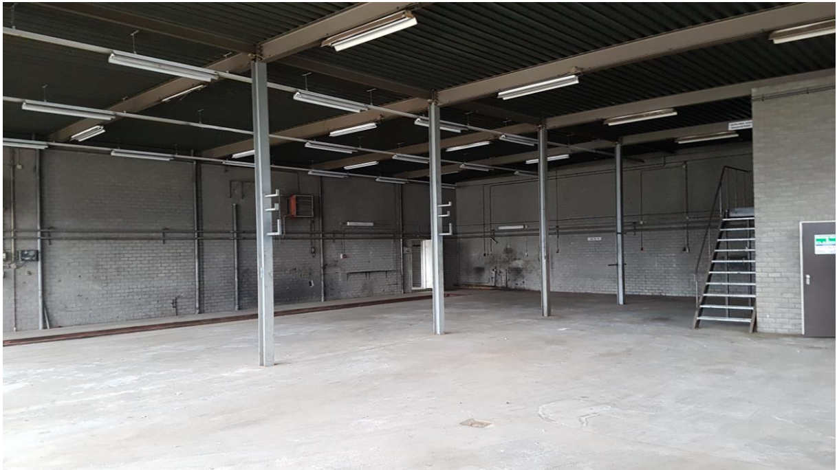
Foto 3: de lege bedrijfshal en dak zonder dakbeschot.
