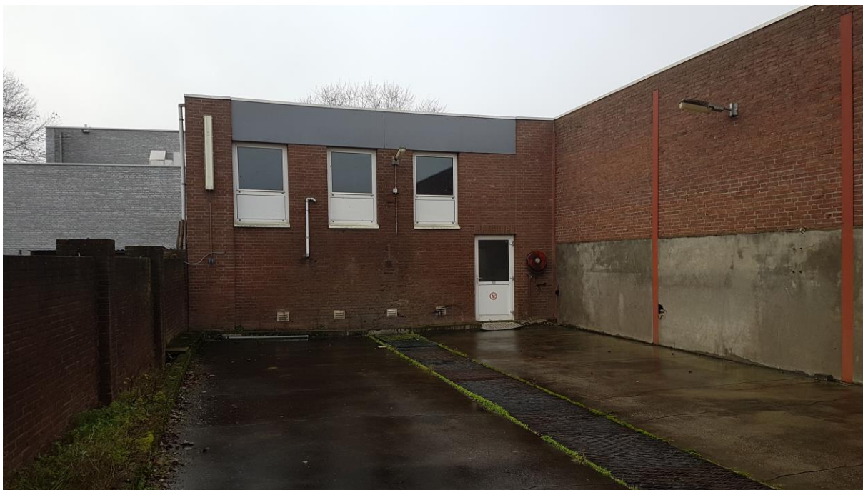
Foto 9: kantoor met in de voorgrond de wasplaats, links in de achterste hoek liggen tegels over een goot.
