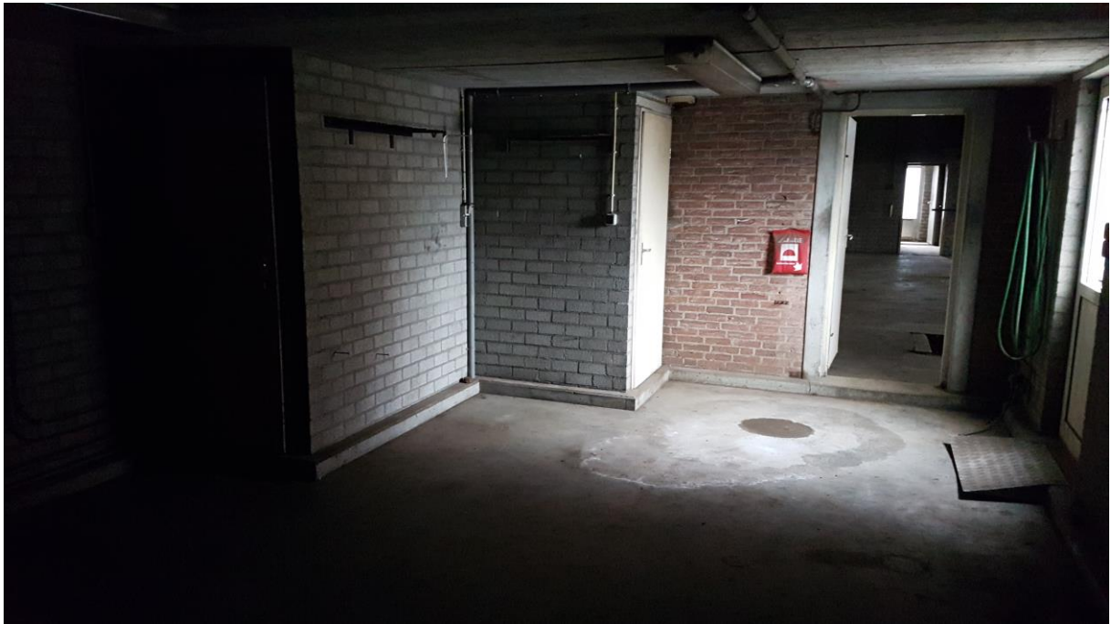
Foto 5: begane grond van het kantoor
