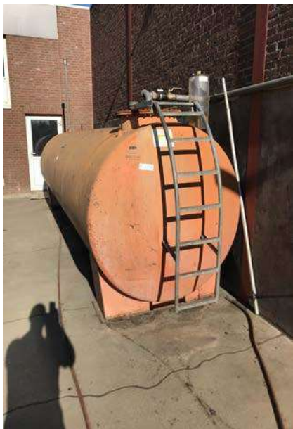
Foto 7. Bovengrondse dieseltank
