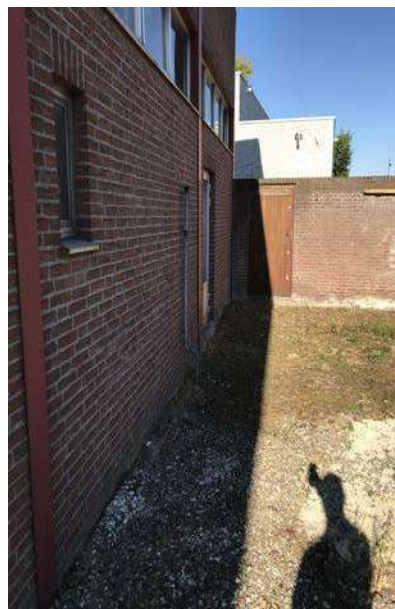
Foto 12. Vml ondergrondse tank
