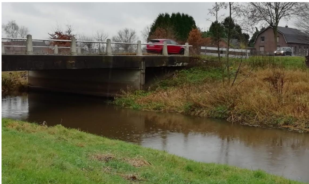
Figuur 2: Overzichtsfoto van de huidige situatie van de auto- en fietsbrug over de Neerbeek.
