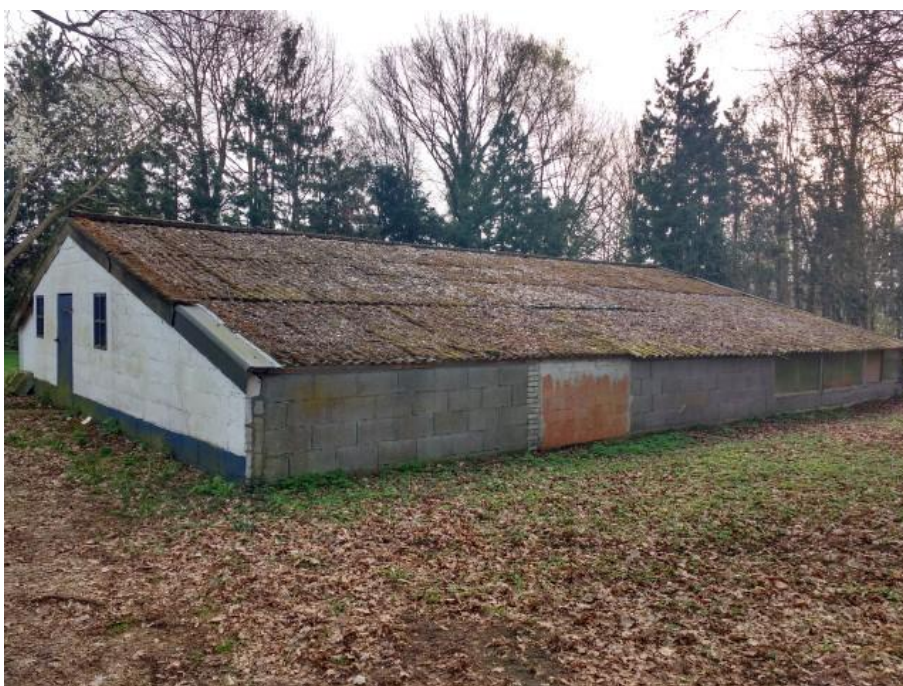
Foto 21: Rijksweg zuid 4 te Kelpen (bebouwing met asbesthoudende golfplaten midden op het perceel)
