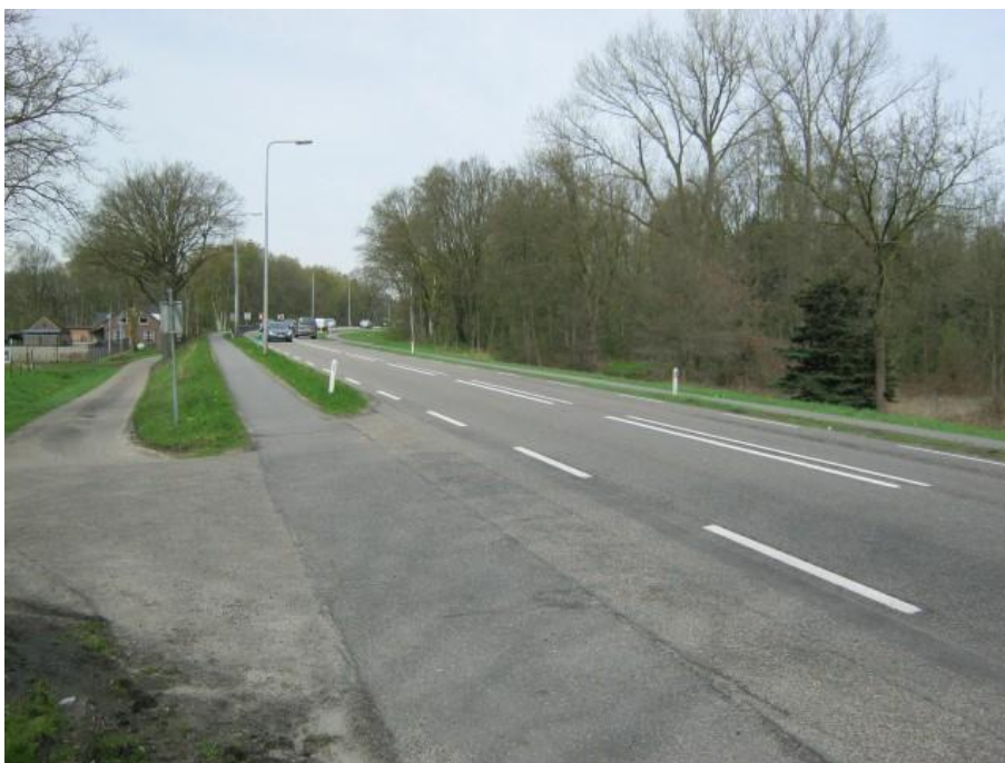
Foto 32: N280, begin van het grondlichaam Kelperbrug
