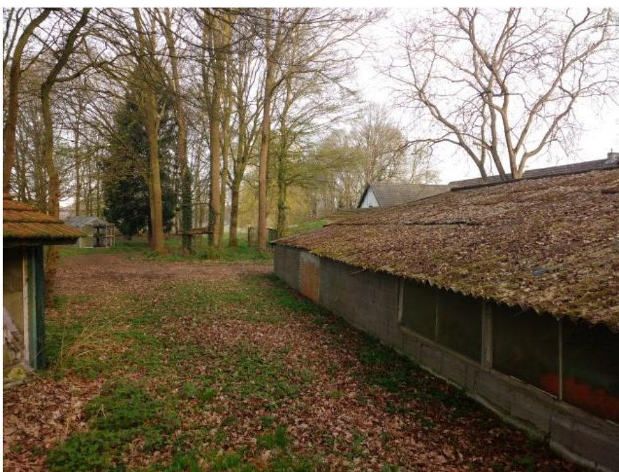
Foto 29: Rijksweg zuid 4 te Kelpen (bebouwing met asbesthoudende golfplaten midden op het perceel)
