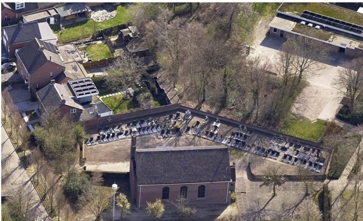
Bestaande woning direct aan de kerkhofmuur
