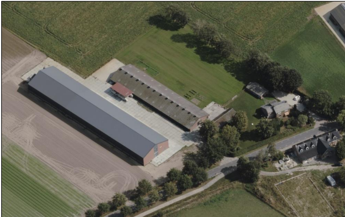
Figuur 2 : Luchtfoto huidige situatie Grathemerweg 3 d.d. 13-09-2020 (bron: Cyclomedia)
