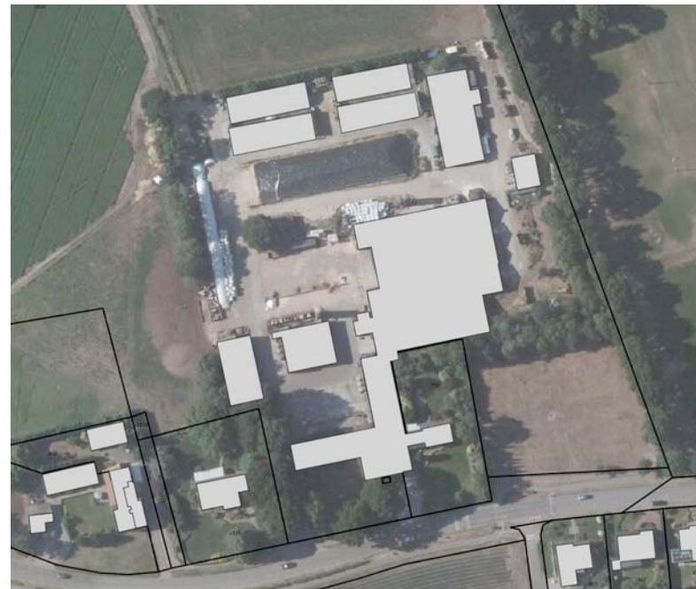
overzicht bebouwing bagviewer
