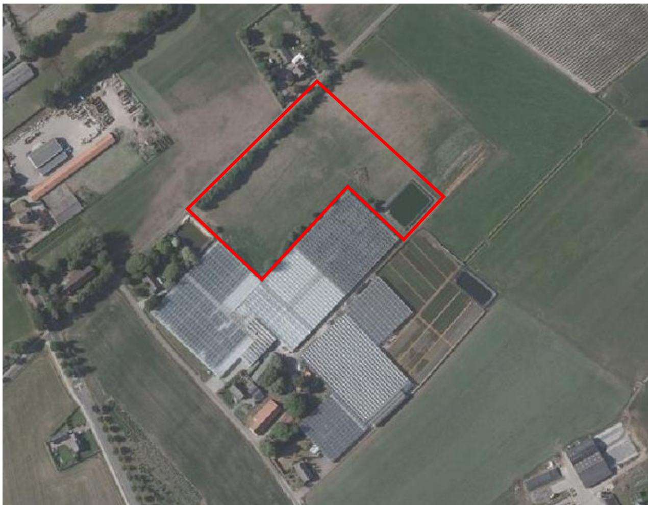
Afbeelding 1: luchtfoto van de onderzoekslocatie [bron: PDOKViewer]
