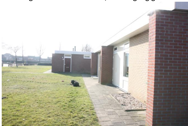
Foto 1: In de grondgebonden woningen is nergens ruimte aanwezig voor huismussen of gierzwaluw voor nestlocaties
