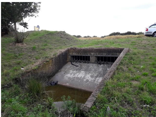
Foto: Oostelijke buffer (overstortvoorziening)
