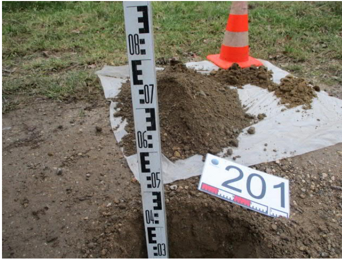
Foto: Inspectiegat IG201 (oostelijke veldweg)
