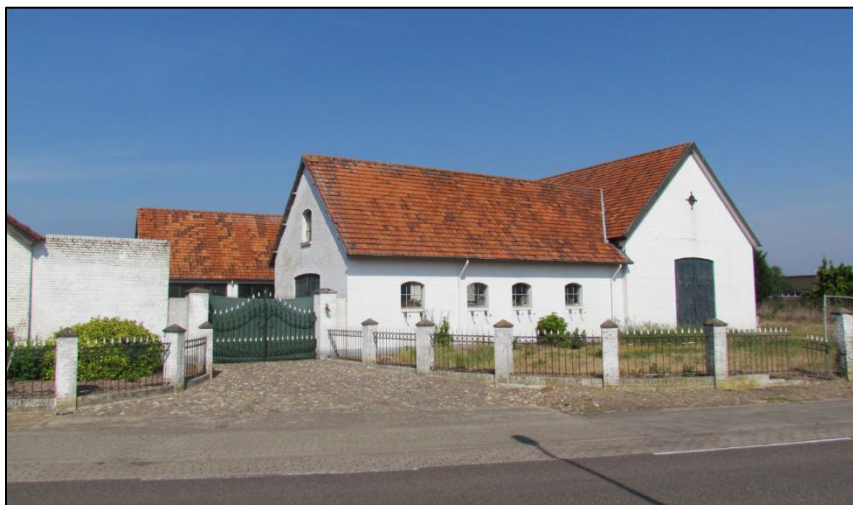
Aanzicht u-vormige bedrijfsgebouw vanaf Kelperweg (toekomstige woning)
