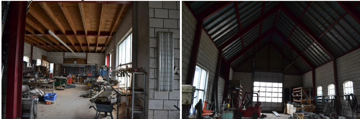
Figuur 1.2 Situatie plangebied ter plaatse waar binnenpands het u-vormige pand wordt verbouwd. De steunbalken onder het dak zijn geschikt als hangplek voor gebouw bewonende vleermuizen (zie par 3.2).
