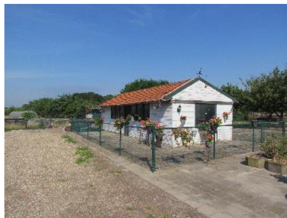
Te verwijderen ontsierende bouwwerken
