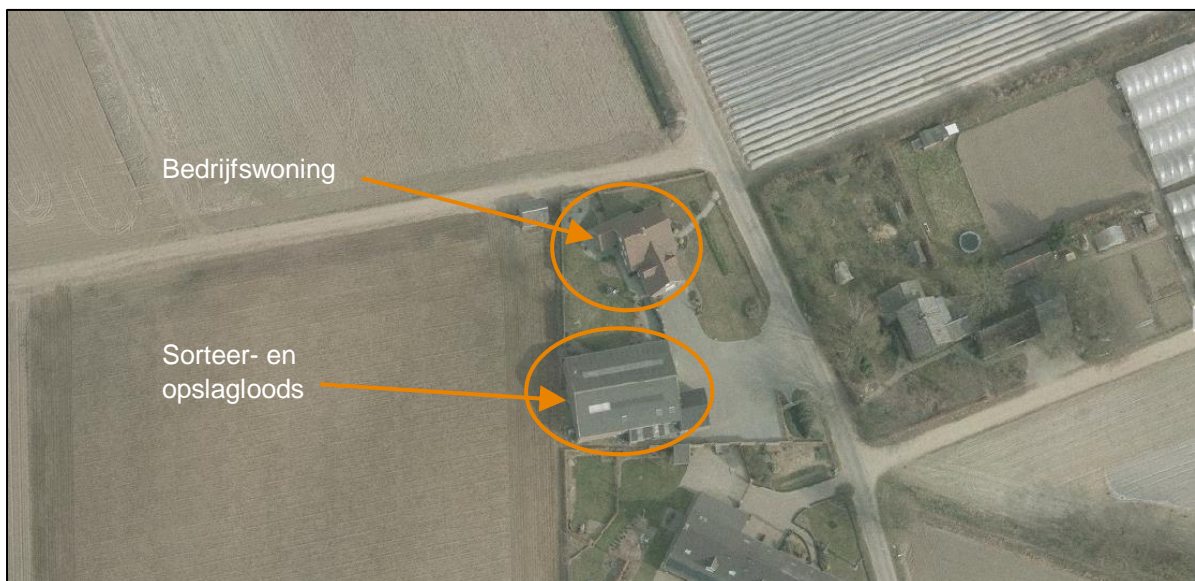
Figuur 1. Luchtfoto bestaande bedrijfsbebouwing
