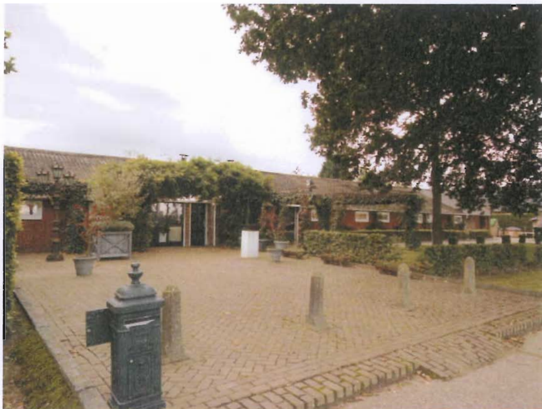
Foto 1: westelijke bedrijfspand (gezien vanuit het noordwesten; 12 september 2012)
