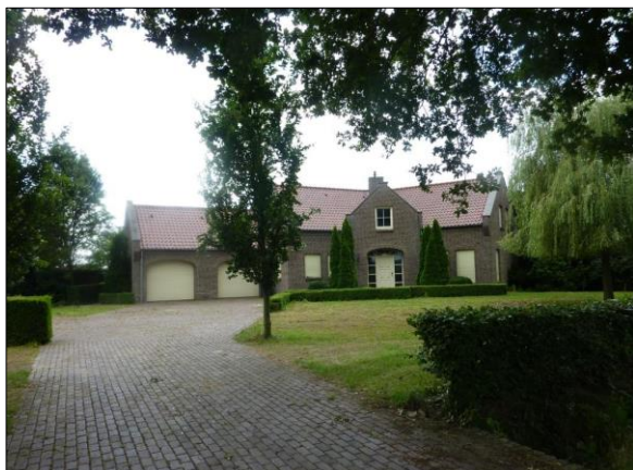
Bestaande bedrijfswoning Graetheideweg 3
