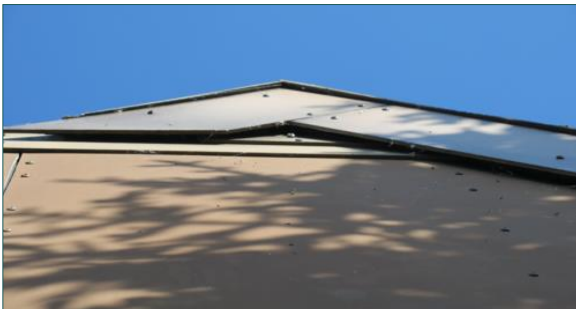
Figuur 3.1 De kunststof platen afwerking op de woning sluit goed aan op de muren en is een te gladde ondergrond voor vleermuizen om de bebouwing te betreden.
