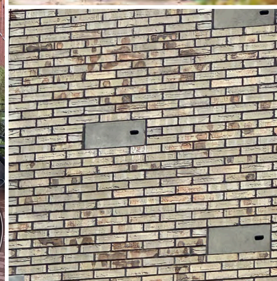
Nestkasten ontworpen als elementen in de gevel
