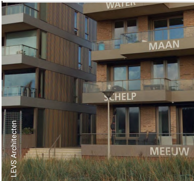
Aandacht voor goede overgang gebouw maaiveld en deels dichte balustrades ter voorkoming inkijk
