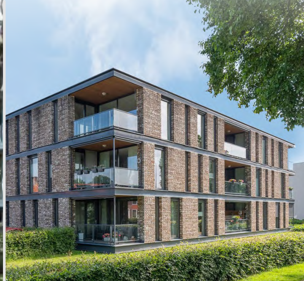
Metselwerk als basis met horizontale accenten
