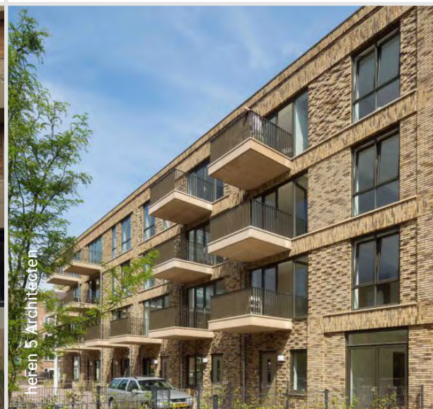
Horizontale accentuering in metselwerk met uitragende balkons
