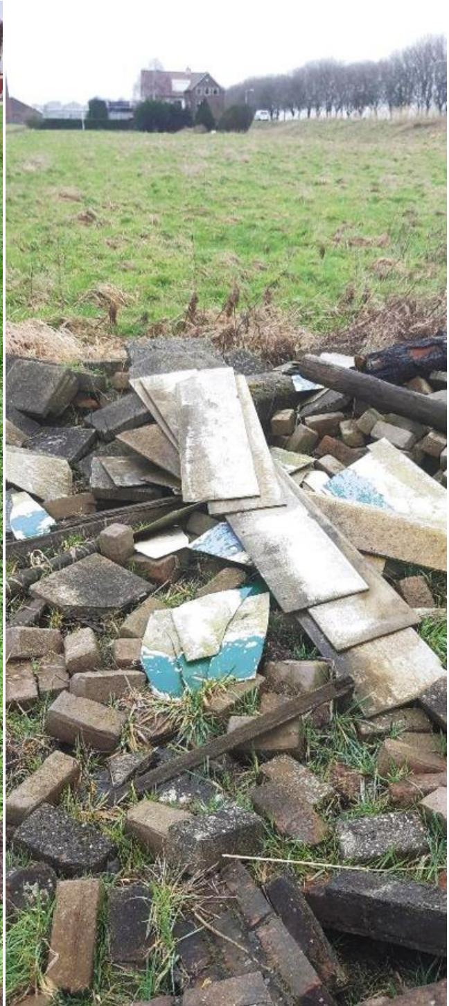
Foto 4: Puindepot, restanten voormalige schuut/ketelhuis
