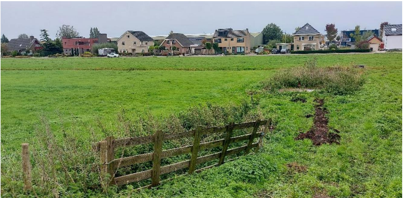
Foto 5: Onderzoekslocatie vanaf de oprit op de dam richting de (rest)verharding voormalige ketelhuis. Zoals op de foto te zien, met de graafmachine toplaag afgeschraapt om te verifiëren dat de puinlaag tot aan de dam loopt.
