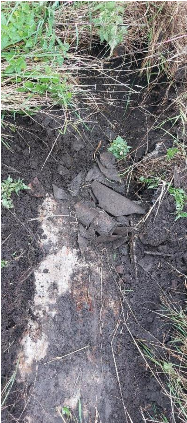
Foto 1: Sleuf A05 (rest)verharding voormalig ketelhuis
