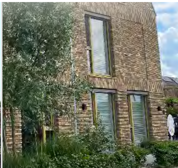
Metselwerkdetails ter verfijning van het volume
