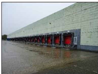
Figuur 2-3. Westgevel bedrijfspand.
