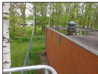
Figuur 13. Zomerkasten, Klappolder 1d, westgevel
