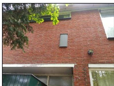
Figuur 5. Zomerkast, Hoefweg 79, westgevel
