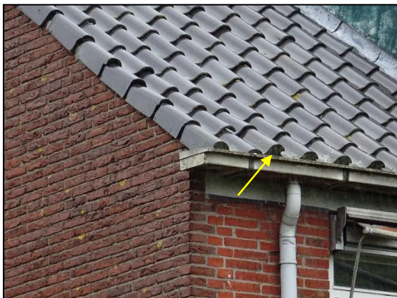
Figuur 34. Ruimte onder dakpannen geschikt als broedplaats huismus.
