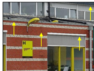
Figuur 48. Open stootvoegen, ruimte onder daktrim en in zonweringkast geschikt als verblijfplaats vleermuizen (deelgebied 6).
