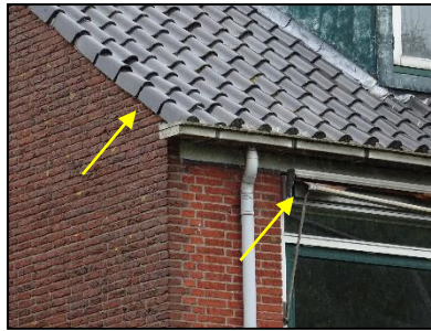
Figuur 39. Ruimte onder overhangende dakpannen en in zonweringkast geschikt als verblijfplaats vleermuizen (deelgebied 1).
