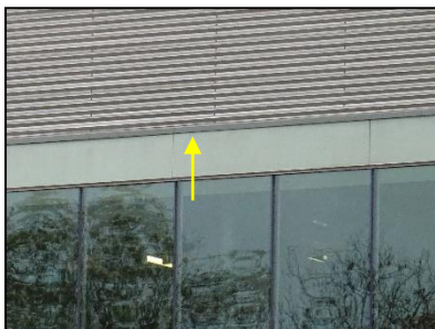
Figuur 41. Ruimte onder daktrim geschikt als verblijfplaats vleermuizen (deelgebied 3).
