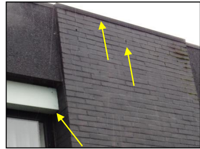
Figuur 40. Open stootvoegen, ruimte onder daktrim en in zonweringkast geschikt als verblijfplaats vleermuizen (deelgebied 2).
