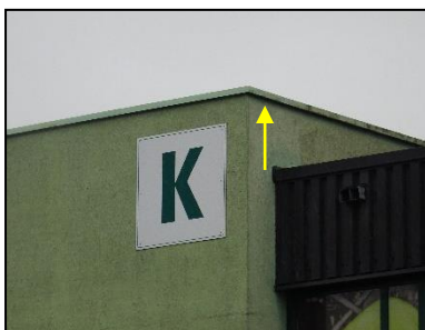
Figuur 47. Ruimte onder daktrim geschikt als verblijfplaats vleermuizen (deelgebied 5).
