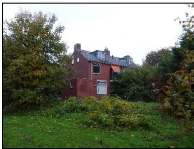
Figuur 3. Vier dubbelwoningen omringd door groen in deelgebied 1 (Klap-polder 77-80).
