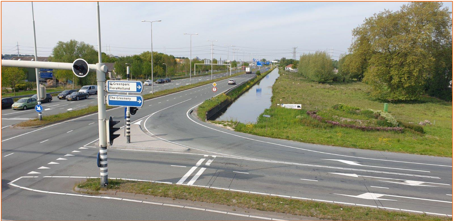
Figuur 3 Huidige situatie aansluiting N209-Hoefweg (bron; eigen foto)
